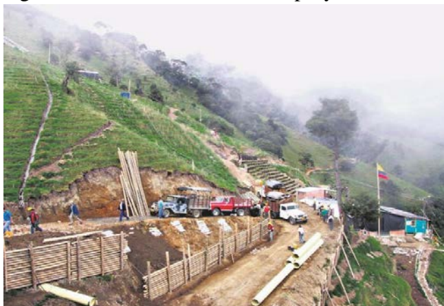
Imagen 4 Infraestructura vial en el proyecto La Colosa
