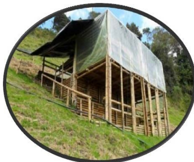
Imagen 5 Plataformas de perforación en el proceso de exploración proyecto La Colosa
