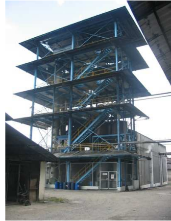
Destilería de Riopaila Industrial S.A
