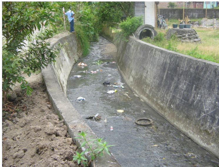
Figura 10. Canal principal de alcantarillado
