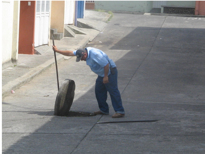
Figura 7. Inspección de cámaras
