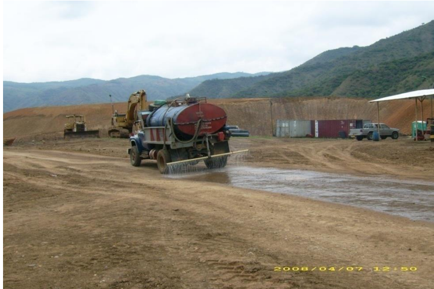
FIGURA 20 CONTROL DE RESIDUOS LIGEROS
