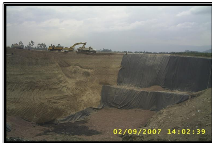
RELLENO SANITARIO TIPO TRINCHERA
