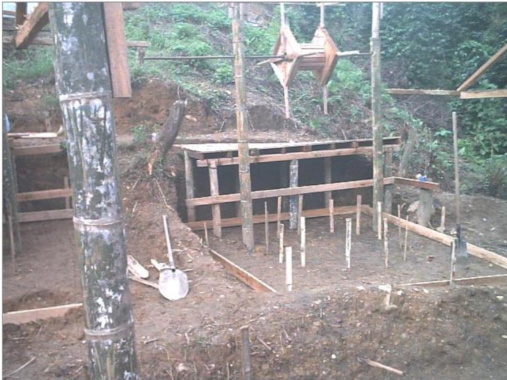
En la fotografía se observa la garrucha; ésta consta del carretel con listones clavados como agarraderas para el trabajador y el carretel con la manila con la cual se amarra el balde para retirar el material sobrante. Este balde por lo regular es de un cuñete de pintura, se le modifica la manilla por una de hierro por lo regular de 3/8 o de 1/4 que van asegurados al balde para mayor resistencia.
