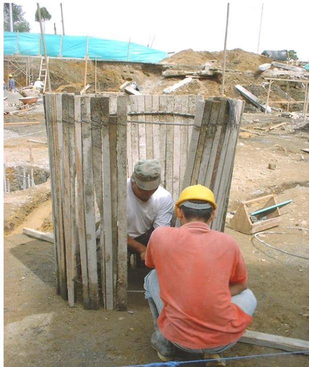
Un oficial y un ayudante, cuadrando la formaleta para fundir un anillo del caisson; esta formaleta es en madera y se deforma mucho en la desencofrada, por esta razón hay que organizarla después de cada vaciada de un anillo, esto demora más el trabajo.
