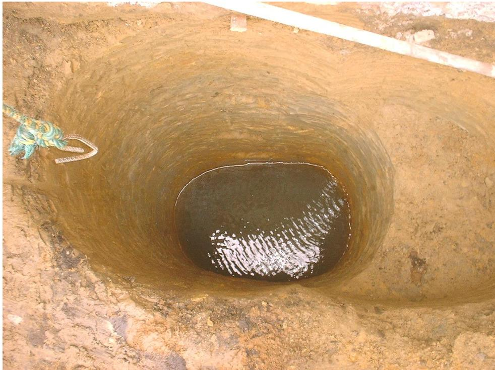
En esta parte de la cimentación, el terreno se sostuvo sin problemas de derrumbamientos, por esta razón no hay necesidad de hacer los anillos en concreto.
