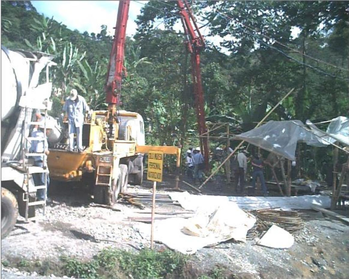
Por el contrario la fundición de la pila o caisson se puede hacer con premezclado, se debe tener cuidado y fundir por tramos de 50 cms preferiblemente y parar para poder vibrar y evitar que queden espacios de aire.
