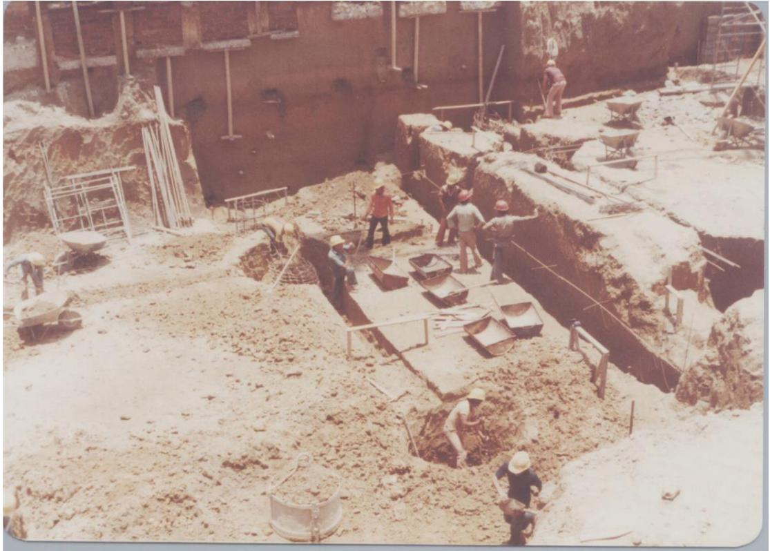
Se puede observar como se inicia la excavación de los caisson, un trabajador a pala inicia la excavación, se puede ver la forma circular de esta, se ve al lado otra excavación ya terminada con el castillo.
