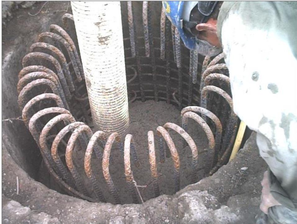
Foto No. 25 Oficial vibrando el concreto, ya llegando al nivel indicado
