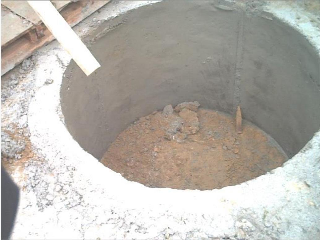
Cuando se va profundizando en la excavación solo puede trabajar uno solo y debe ubicar el castillo del anillo, la formaleta y todo lo que necesite con mucha dificultad por lo estrecho.
