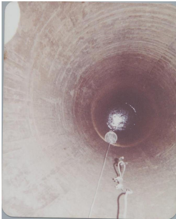
Aquí se observan varios procesos ya terminados tales como la excavación, el vaciado de los anillos que son las paredes también se ha llegado a la profundidad deseada, el siguiente paso es introducir el castillo y asegurarlo.
