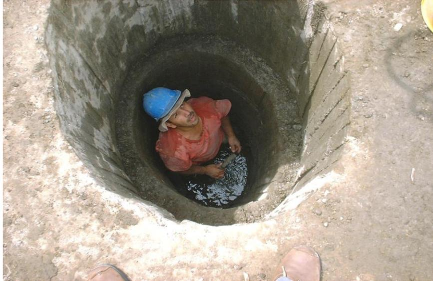
Con una profundidad aproximadamente de 3 mts, ya se observa el nivel freático, se debe sacar el agua para poder continuar la excavación.
