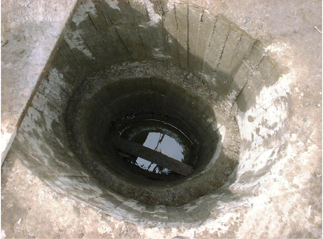
En la fotografía se observa un caisson con dos anillos vaciados, el nivel freático ya es más alto.
