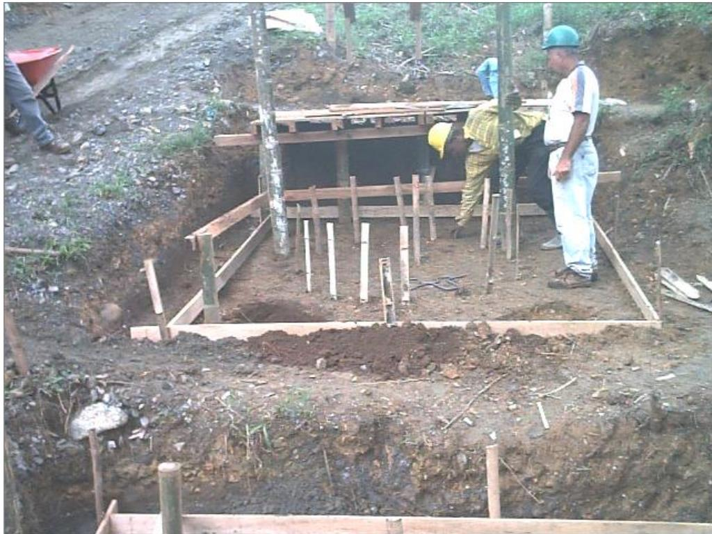
Además de la formaleta para el mortero, antes de vaciar el solao se debe clavar unas guaduas en el terreno, una a cada lado del caisson o pila, bien plomadas, para la garrucha, la cual facilita el trabajo.
