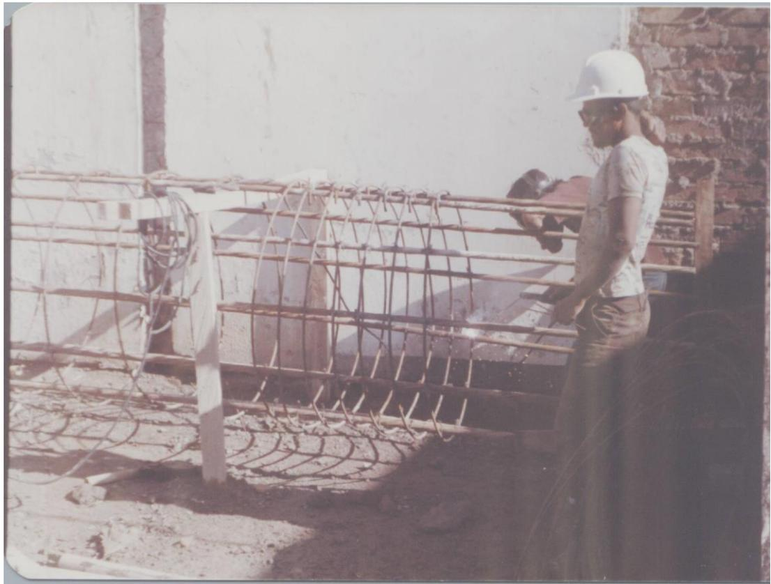
Como armar un castillo de caisson para luego introducirlo en la excavación este sistema no se ha mencionado anteriormente, ya que va soldado.
