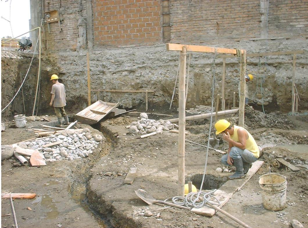
En esta obra no utilizaron la garrucha para retirar el material sobrante de la excavación.
