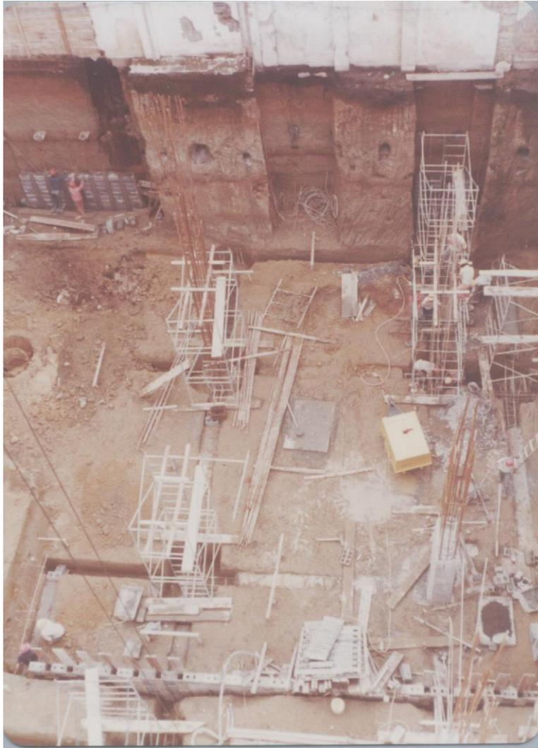
En la fotografía se observa desde una vista superior, una cimentación caisson. A la izquierda se observa un caisson que se encuentra listo para ser fundido ya se le ha introducido el castillo y en el momento se encuentran llenos de agua, esta se tiene que sacar para poder empezar a vaciar el
