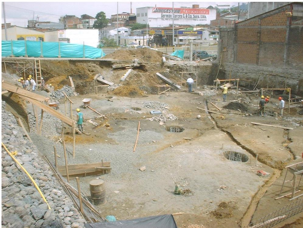
En esta toma desde una parte alta se puede observar como trabajan las perforaciones de los caisson simultáneamente, al igual que las brechas que utilizaron para evacuar el agua que sacan de los caisson
