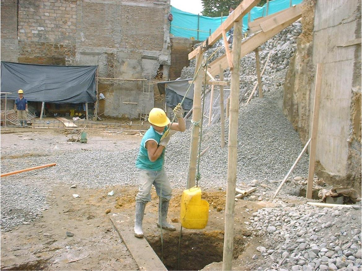
El nivel freático no es muy alto y permite a los obreros sacar el agua por medio de baldes o galones adecuados mientras continúan con la excavación.
