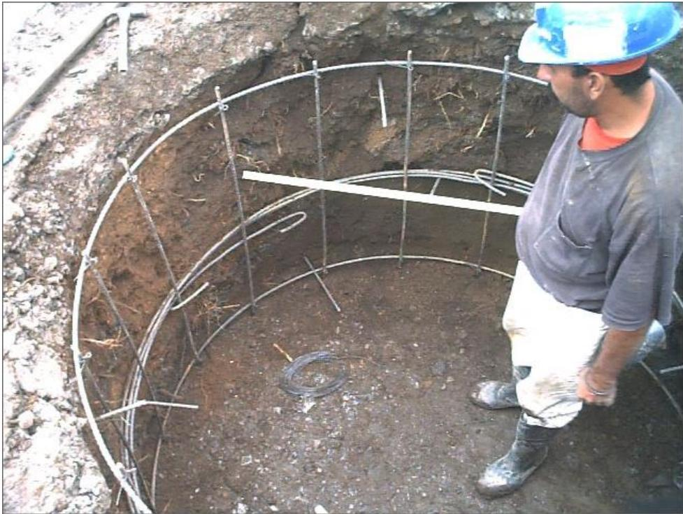
En esta fotografía se muestra que se ha excavado el primer tramo y el castillo se introdujo en la excavación para determinar cuales son sus medidas ya que es más ligero formaletear antes y después de ubicada la formaleta introducir el castillo. Se puede observar que el castillo de la fotografía anterior llevaba más refuerzo esto se debe que este irá a más profundidad donde soportará más presión.
