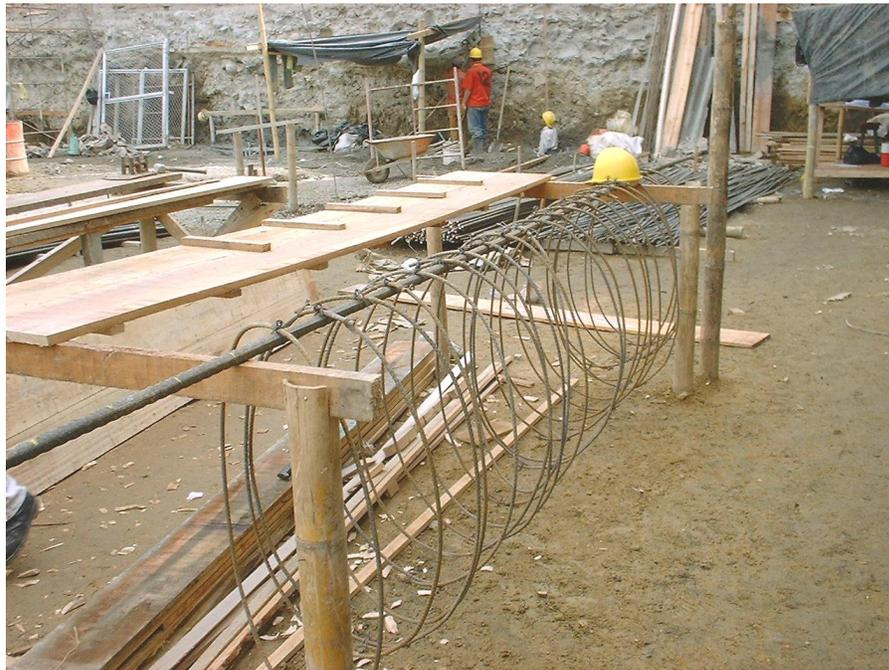
La profundidad de estos caisson no sobrepasan los 6 mts y la estructura solo tiene 2 niveles, por esta razón el castillo del caisson lleva poco hierro y pueden armar el castillo a fuera e introducirlo al caisson por medio de manilas.
