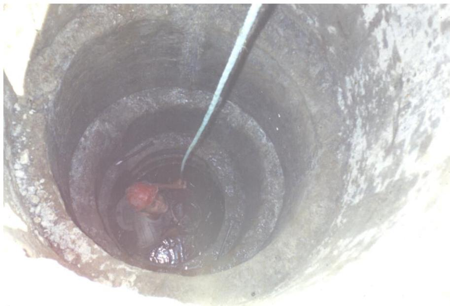
Foto No. 45. Vaciado de anillo
