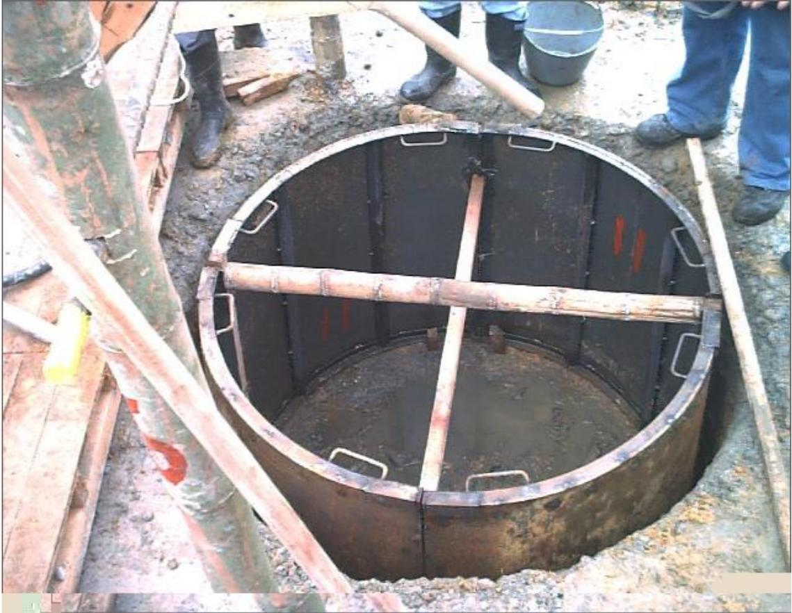
La formaleta se arma dentro del agujero, esta debe ser ubicada y centrada de acuerdo a los ejes. Después de centrarla en el agujero se debe apuntalar con estacas clavadas en el terreno, esto en su parte inferior y en la parte superior con trabillas como se observa en la fotografía.
