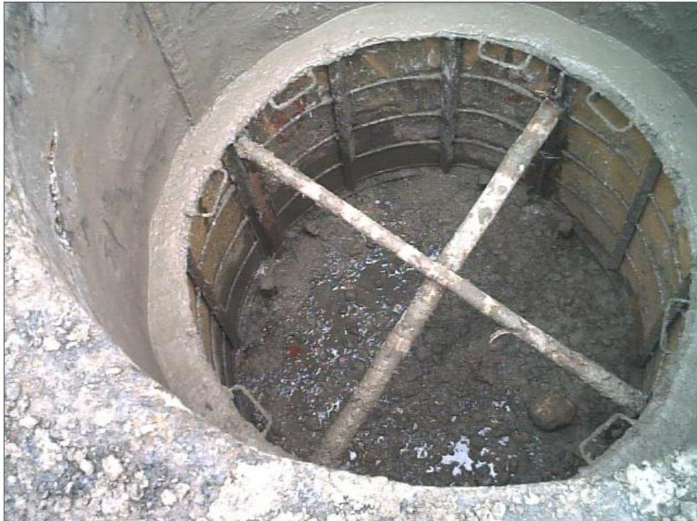
Se observa el segundo anillo vaciado y es vaciado igual al perímetro solo que hay que tener cuidado con el segregado del concreto. Es importante resaltar que la formaleta utilizada en este caso es de mayor diámetro en su parte superior que en la inferior, por esto a medida que se va profundizando, entre cada anillo va quedando una pestaña, esto se conoce en el medio como pata de elefante y evita asentamientos de los anillos ya que no van apoyados uno del otro, sino en el terreno.
