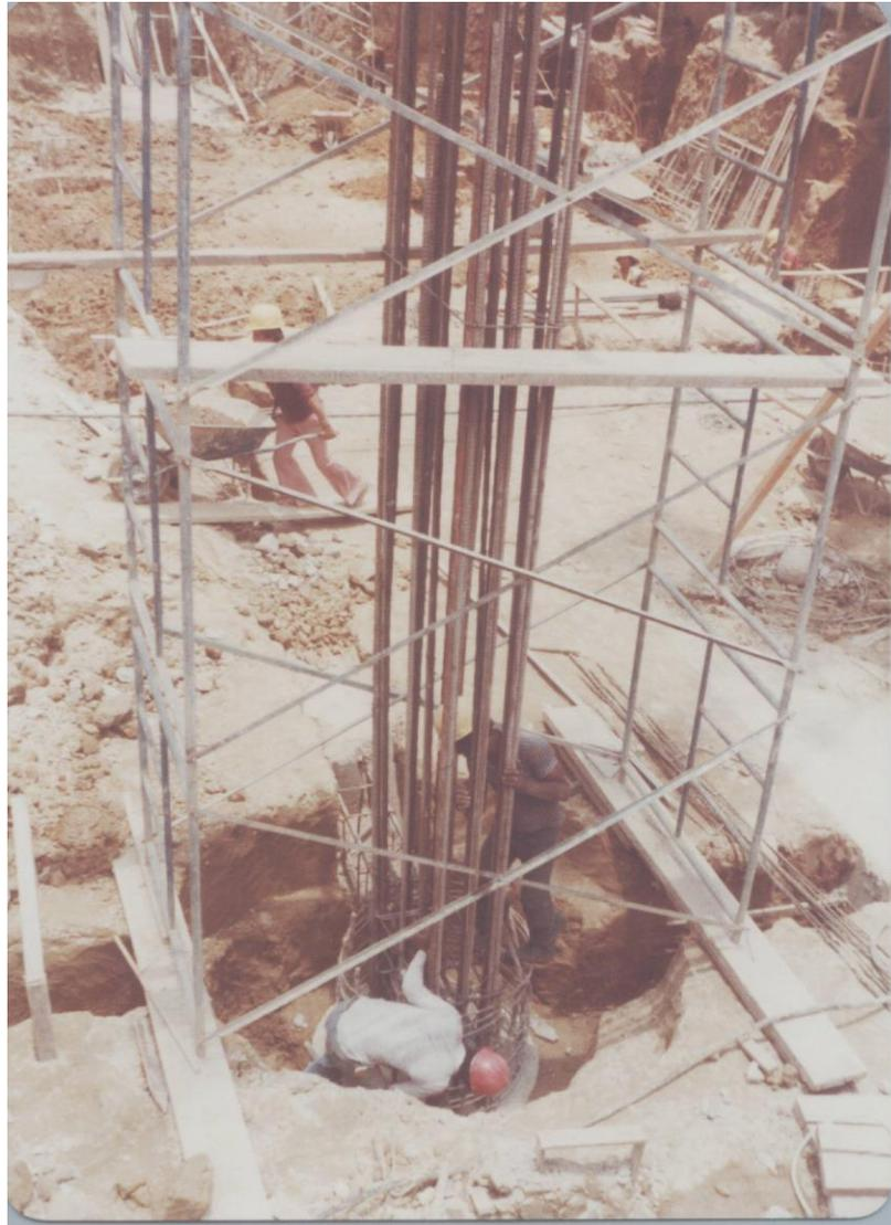
Se puede ver el dado con mucha claridad, en este proceso ya se ha vaciado el caisson completamente. Se observa hasta donde llega el hierro del caisson y el nudo que se forma con el hierro de la columna, también debe entrar el hierro de la viga de cimentación.
