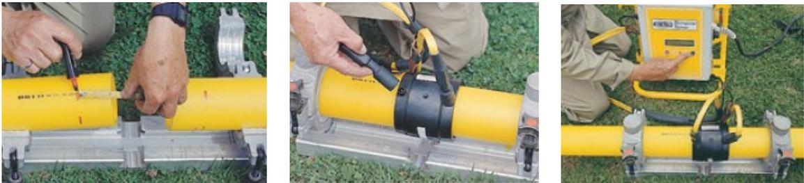
No se debe retirar la herramienta hasta haber completado el ciclo de fundición y enfriamiento.
