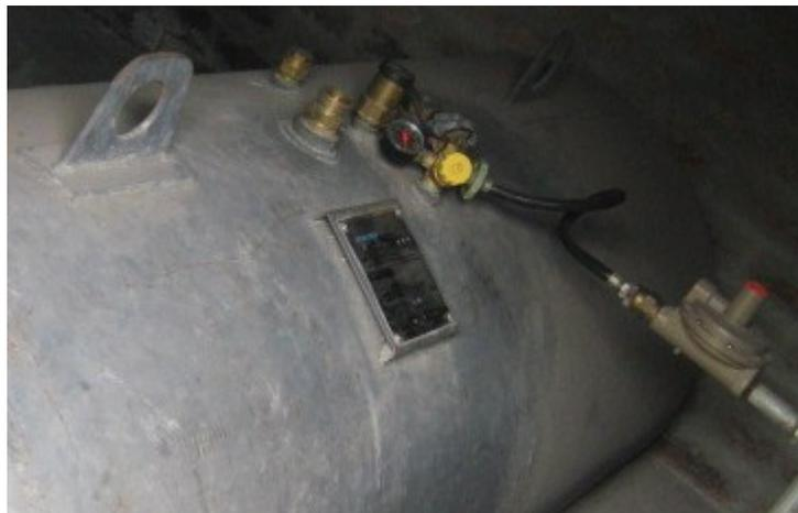
Para la fabricación de los recipientes el fabricante debe cumplir con el código ASME (Sociedad Americana de Ingenieros Mecánicos) y las especificaciones técnicas deben ser suministradas en una placa adherida al tanque.
