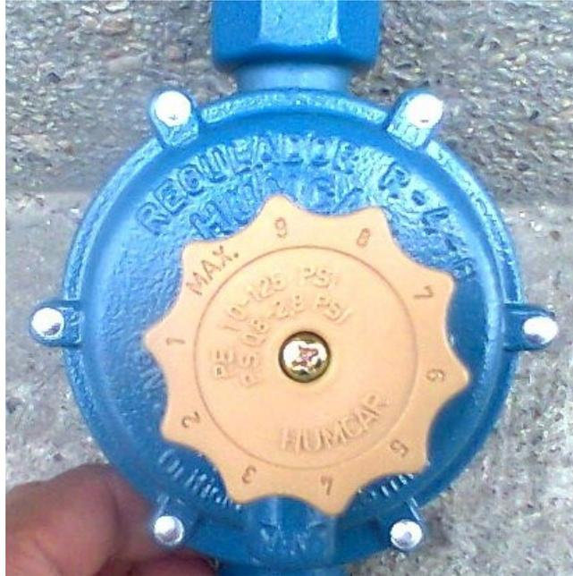
Este regulador tiene un caudal de salida de  $3 \text{ m}^3/\text{h}$  y el caudal requerido en cada vivienda es de  $2.01 \text{ m}^3/\text{h}$ ; por tanto es adecuado para el sistema. Además éste regulador cuenta con un dispositivo que le permite manipular la presión de salida hasta 2.8 PSI; esto puede ser tenido en cuenta para el caso de regulación en dos etapas que veremos mas adelante.
