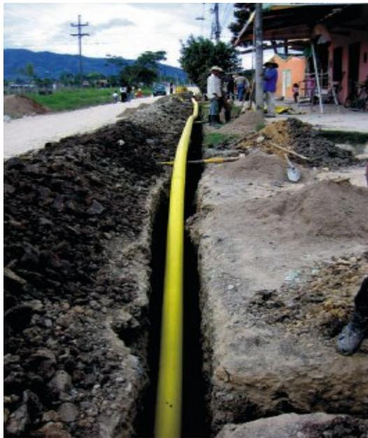
Cualquier tubería que conduce gas se debe proteger contra daño mecánico ya sea encamisándola o agregando otro tipo de señalización superficial (postes). Debe conservar distancias prudentes con respecto a otros servicios, lo recomendado es un mínimo de 20cm en paralelo y 10 cm en cruce.
