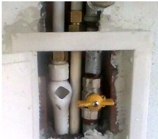
5. Las tuberías de agua caliente y agua fría también deben conservar una distancia prudente entre sí; sobre todo si la conducción de agua caliente se hace en tubería metálica.
