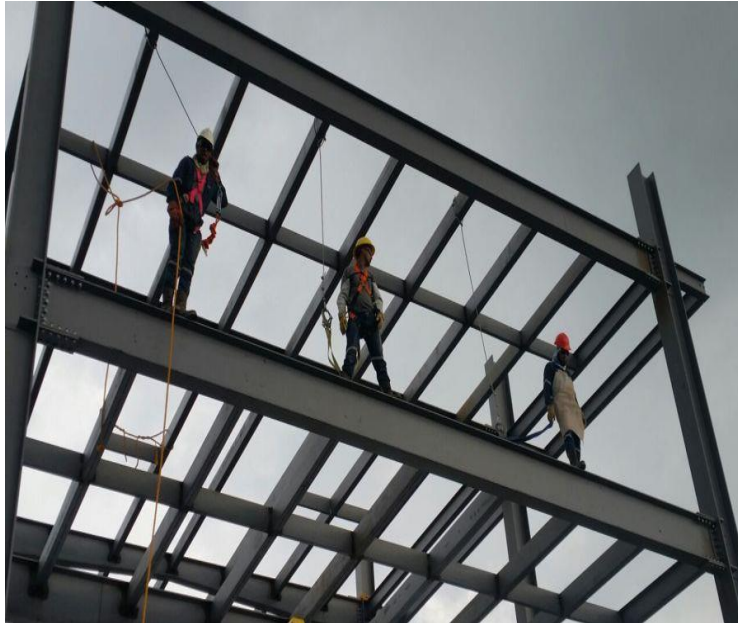
Ilustración 2. Estructura metálica. Fuente propia
