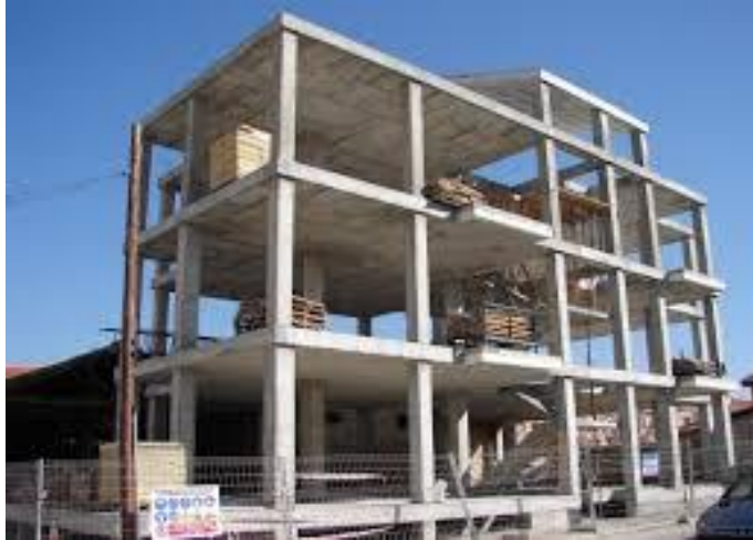
Ilustración 1. Estructura en Hormigón. Fuente propia
